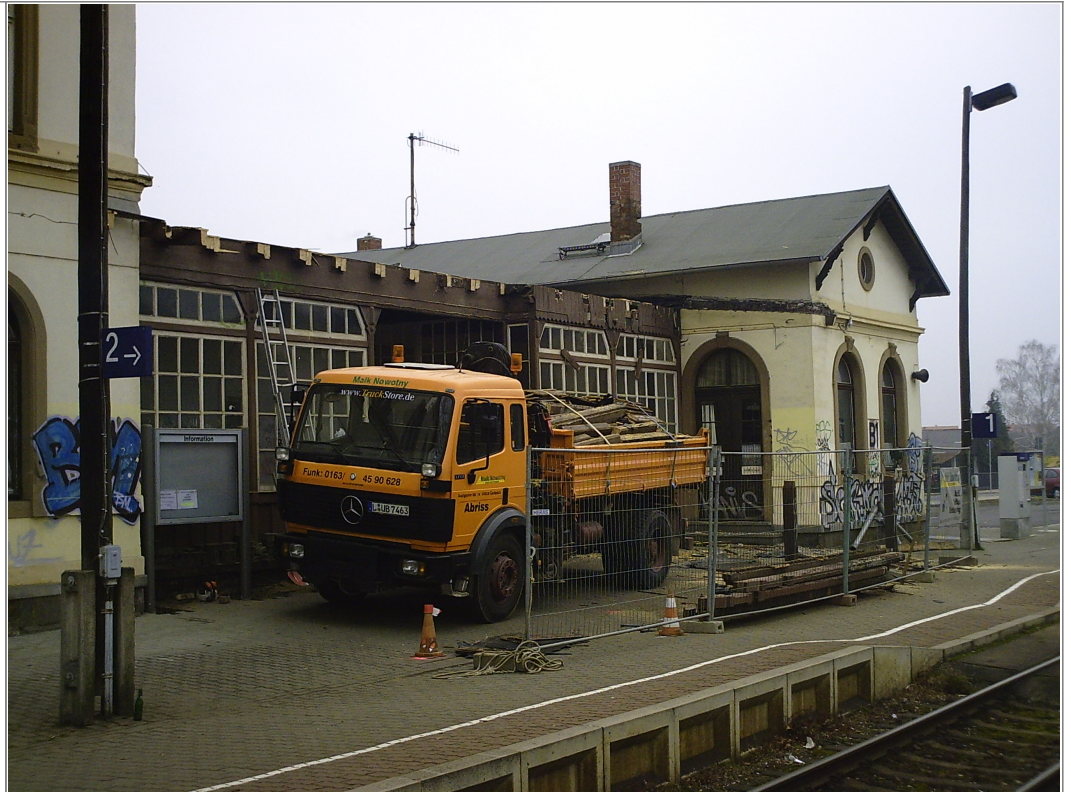
Umbau Bahnhof Naunhof 2004
